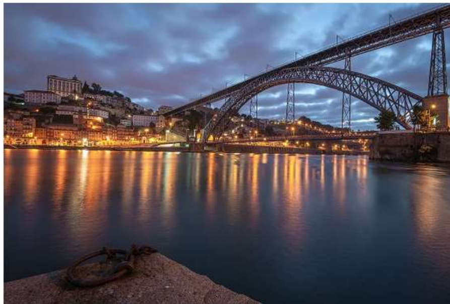
Ponte de D. Luís, no Porto.
